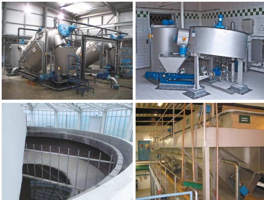
Рис. 1. Примеры реализации КТР «МУ-Solid» компанией «МАЙ ПРОЕКТ». ВВЕРХУ СЛЕВА — БАРАБАНЫЕ СГУСТИТЕЛИ, ВВЕРХУ СПРАВА — ДИСКОВЫЙ СГУСТИТЕЛЬ, ВНИЗУ СЛЕВА — КРЫТЫЙ ГРАВИТАЦИОННЫЙ УПЛОТНИТЕЛЬ С РАМНОЙ МЕШАЛКОЙ, ВНИЗУ СПРАВА — ФЛОТАТОР ДЛЯ СГУЩЕНИЯ ИЛА
