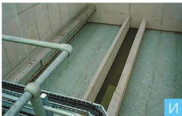
Рис. 8. Операции по созданию монолитного фильтрующего дна с гофрированными панелями в готовом фильтре:
