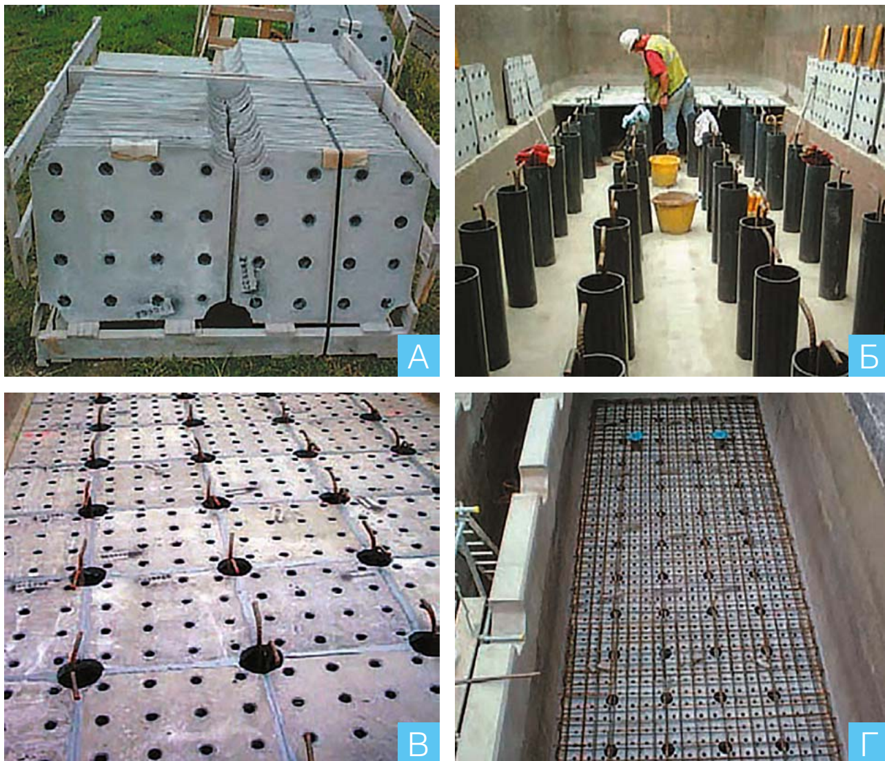
Рис. 9. Операции по созданию монолитного фильтрующего дна с плоскими панелями:
