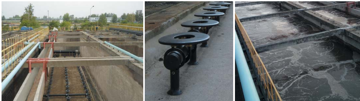
Рис. 4. СИСТЕМА АЭРАЦИИ, УЛОЖЕННАЯ НА ДНЕ АЭРОТЕНКА И В РАБОТЕ
