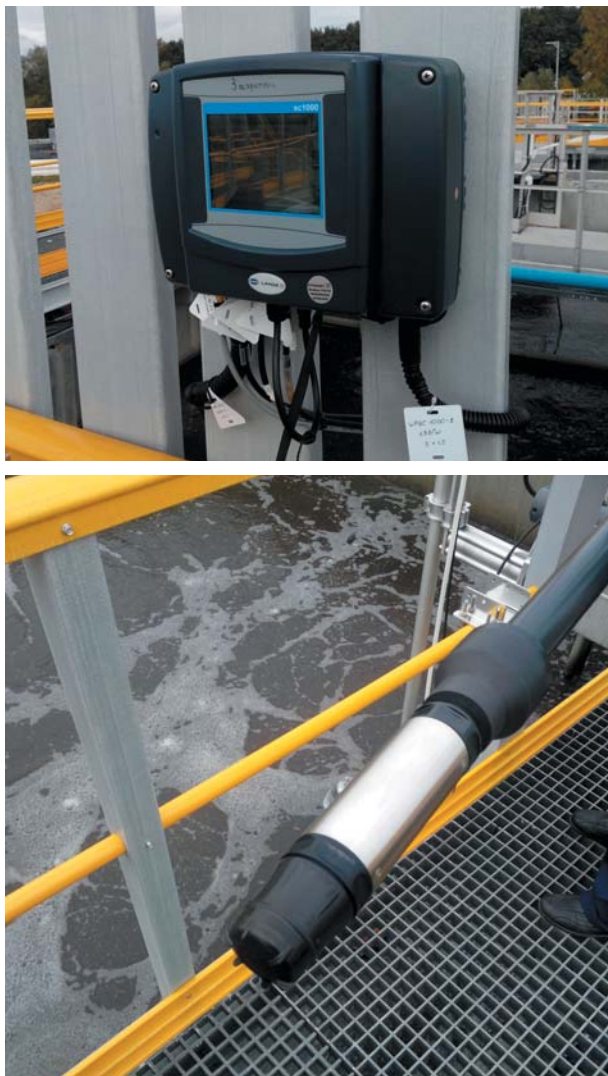
Рис. 7. Вторичный преобразователь с модуль-дисплеем и датчик КРК
