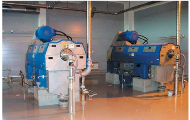
Рис. 4. Декантеры WESTFALIA SEPARATOR на Юго-западных очистных сооружениях
