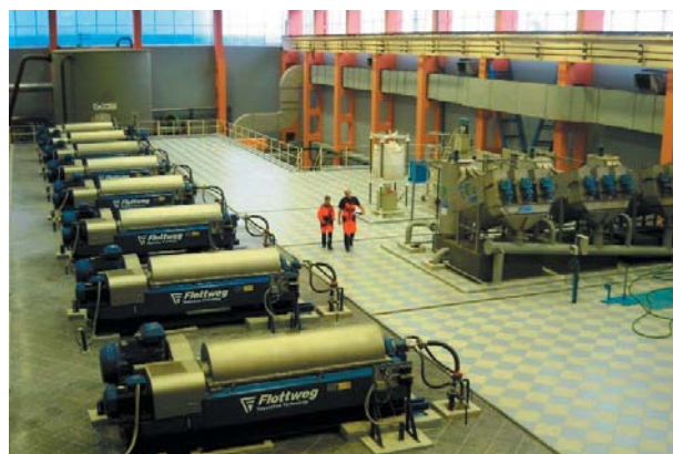
Рис. 2. ДЕКАНТЕРЫ «FLOTTWEG SE» НА ЦЕНТРАЛЬНОЙ СТАНЦИИ АЭРАЦИИ
