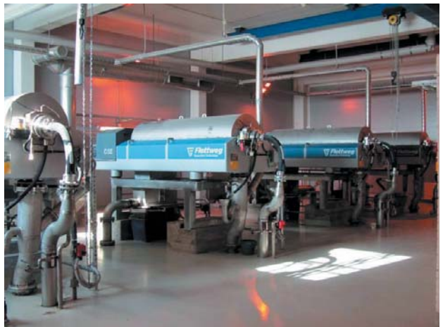
Рис. 6. Декантеры Флоттвег на Юго-Западных очистных сооружениях
