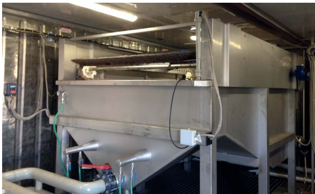
Рис. 8. Общий вид флотационной установки в контейнере на ЛОС ЗАО «Агротек Холдинг»
