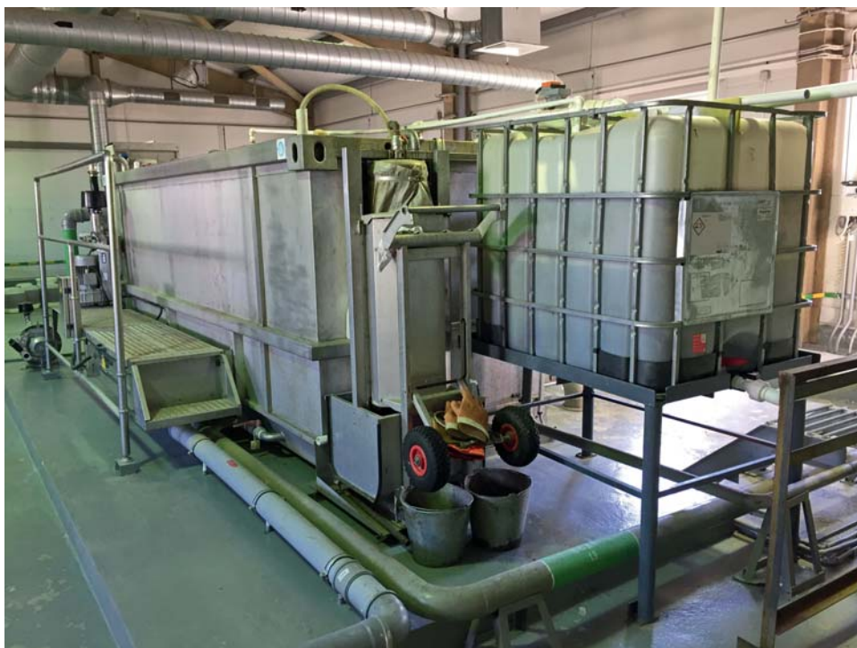
Рис. 7. Внешний вид установки с усреднительной емкостью после проведения работ
