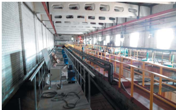
Рис. 4. МОСТИК ДЛЯ УСТАНОВКИ МЕШАЛОК КАМЕР ХЛОПЬЕОБРАЗОВАНИЯ
