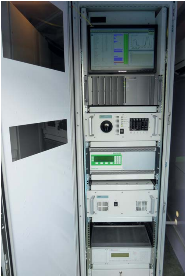
Рис. 8. ШКАФ С ПРИБОРАМИ НЕПРЕРЫВНОГО КОНТРОЛЯ СОДЕРЖАНИЯ ЗАГРЯЗНЕНИЙ В ВЫБРАСЫВАЕМЫХ ДЫМОВЫХ ГАЗАХ
