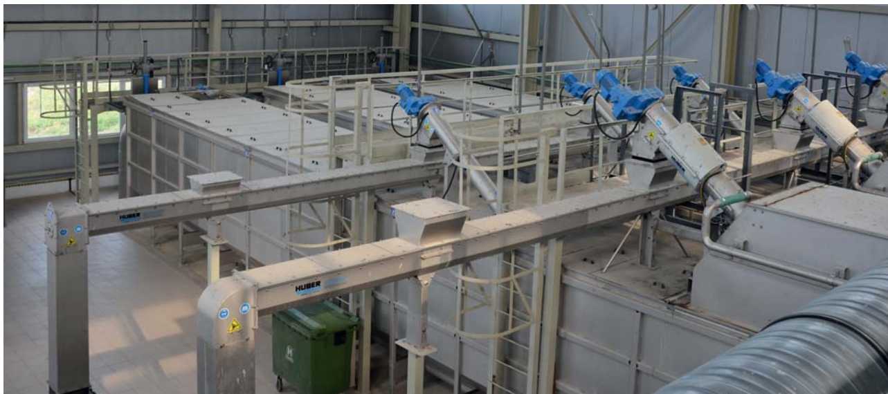
Рис. 1. Новые песколовки в отделении механической очистки
