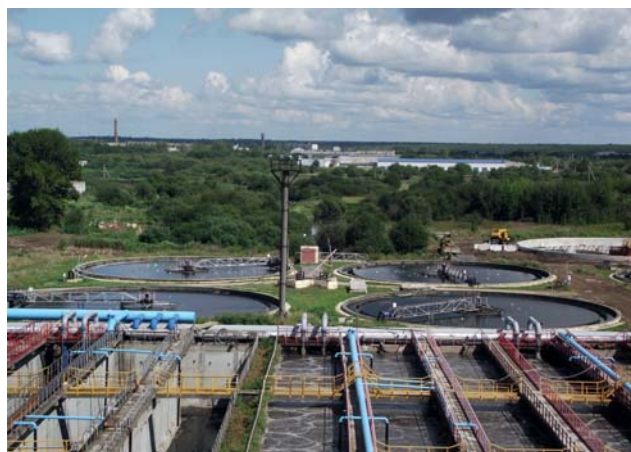
ОСК г. Вологда (аэротенки, вторичные отстойники)
