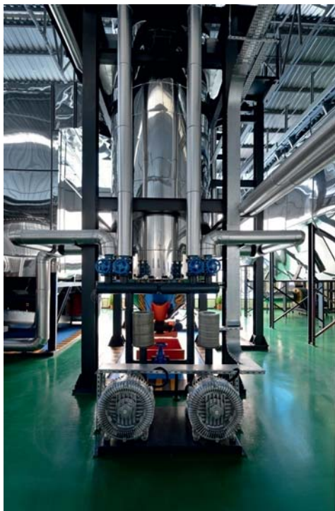
Рис. 6. Узел подачи дутьевого воздуха на две технологические линии сжигания
