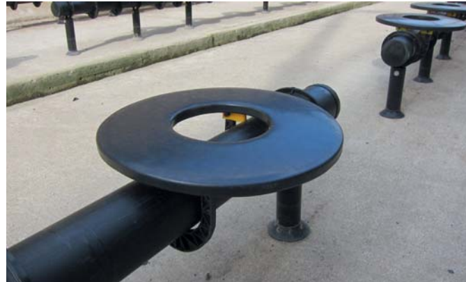
Рис. 4. Аэраторы АКВА-ТОР в аэротенках на Люберецких очистных сооружениях АО «Мосводоканал»
