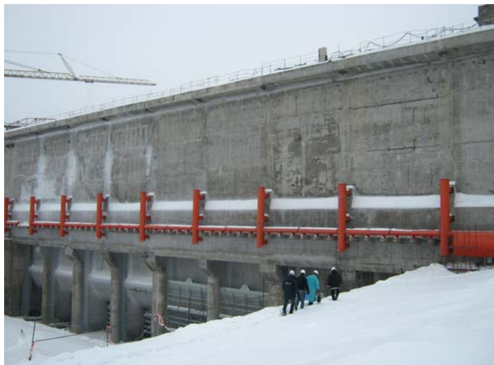
Рис. 3. СТРУГЕНЕРАТОРЫ РЫБОЗАЩИТНЫХ СООРУЖЕНИЙ ЗАГОРСКОЙ ГАЭС-2, ОРИЕНТИРОВАННЫЕ ВЕРТИКАЛЬНО ВВЕРХ
