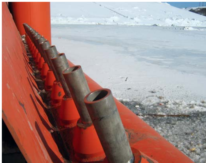
Рис. 3. СТРУГЕНЕРАТОРЫ РЫБОЗАЩИТНЫХ СООРУЖЕНИЙ ЗАГОРСКОЙ ГАЭС-2, ОРИЕНТИРОВАННЫЕ ВЕРТИКАЛЬНО ВВЕРХ
