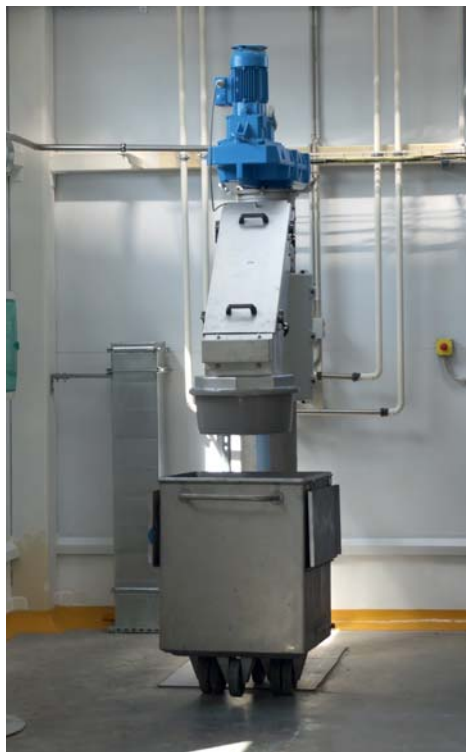
Рис. 7. ВЕРХНЯЯ ЧАСТЬ ВЕРТИКАЛЬНОЙ ШНЕКОВОЙ РЕШЕТКИ
