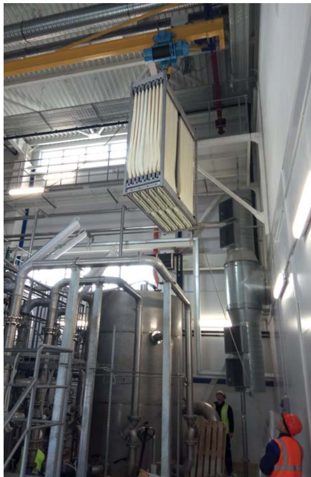
Рис. 11. Монтаж мембранных кассет на ЛОС ООО «Пепсико Холдингс», г. Домодедово
