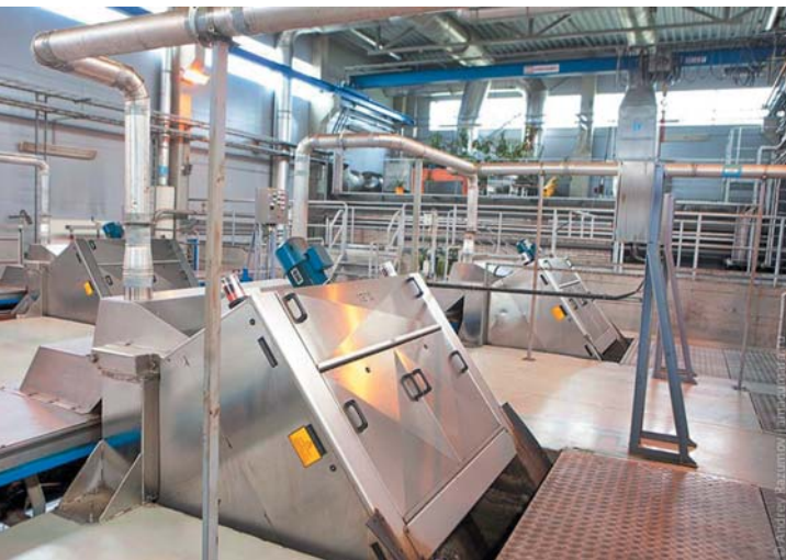
Рис. 4. РЕШЕТКИ В ОТДЕЛЕНИИ МЕХАНИЧЕСКОЙ ОЧИСТКИ
