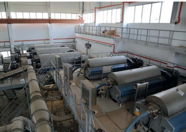
Центрифуги в реконструированном цехе механического обезвоживания
