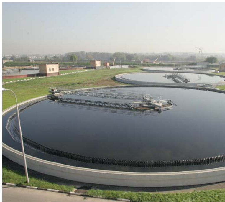
Вторичный отстойник блока удаления биогенных элементов
