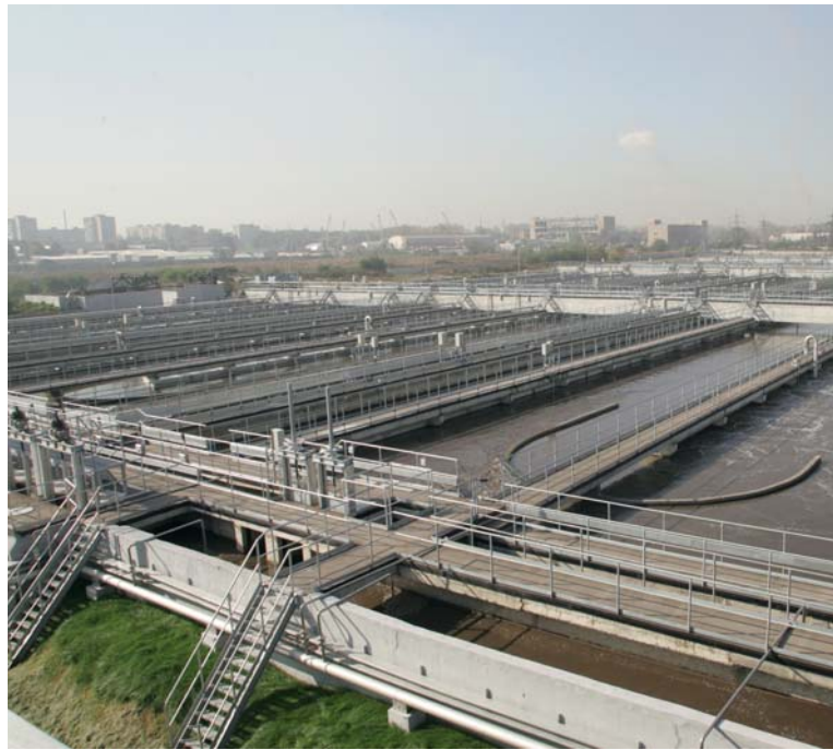
Общий вид аэротенков блока удаления биогенных элементов
