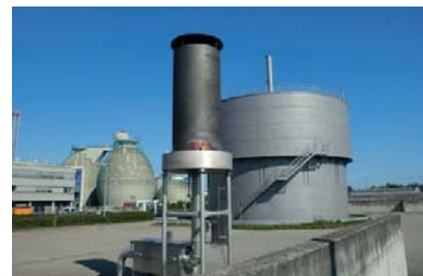
Рис. 4. Метантенки, газгольдер и «свеча» на ОС г. Любек
