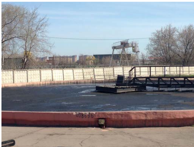
Уплотнитель сброженного осадка (выведены из эксплуатации после внедрения центрифуг)
