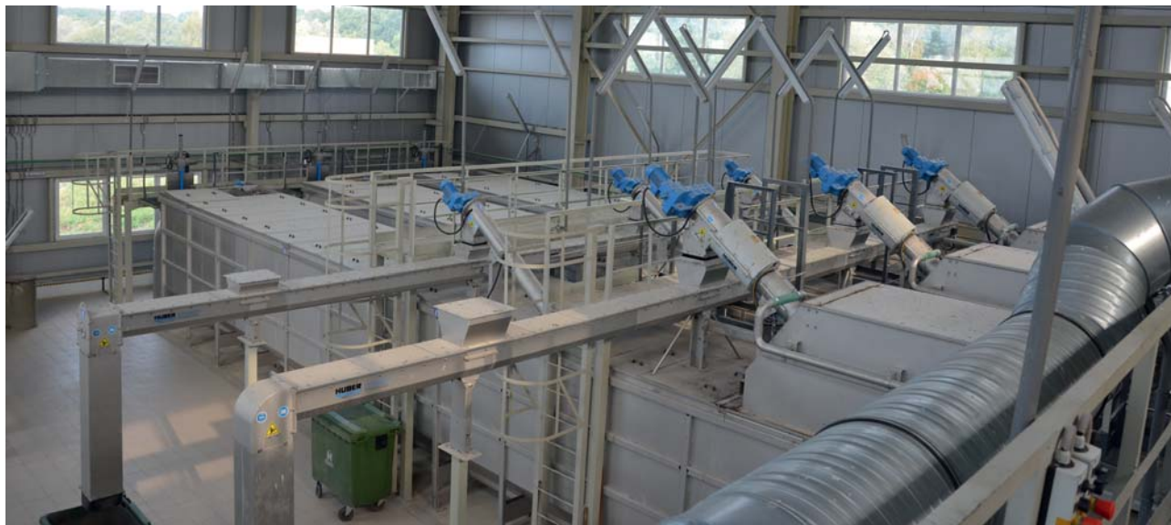
Рис. 6. Технологические решения: MY SCREEN и MY GRIT на ОКОС п. Заостровье
