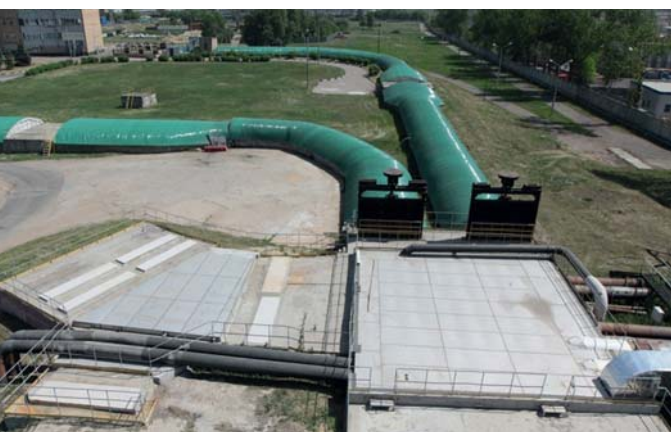
Приемная камера ЛОС и подводящие каналы к зданиям решеток (полностью перекрыты)
