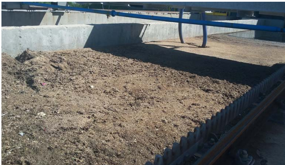
Рис. 8. СКОПЛЕНИЕ ВСПЛЫВАЮЩИХ Веществ — РЕЗУЛЬТАТ НЕПРАВИЛЬНО ЗАПРОЕКТИРОВАННОГО ВЫПУСКА И ОТСУТСТВИЯ ПОВЕРХНОСТНОГО СКРЕБКА
