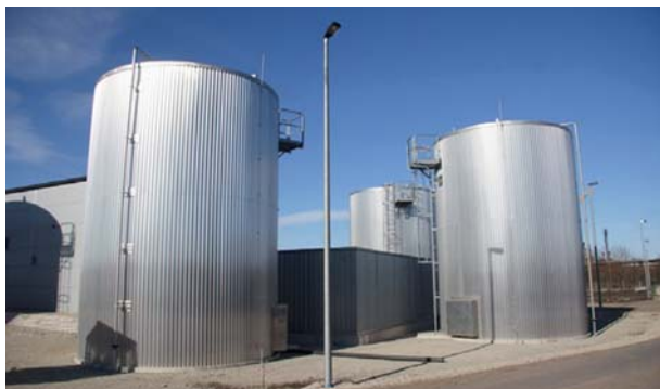
Рис. 10. РЕАКТОРЫ ПАСТЕРИЗАЦИИ ОСАДКА НА ОС КОХТЛА-ЯРВЕ
