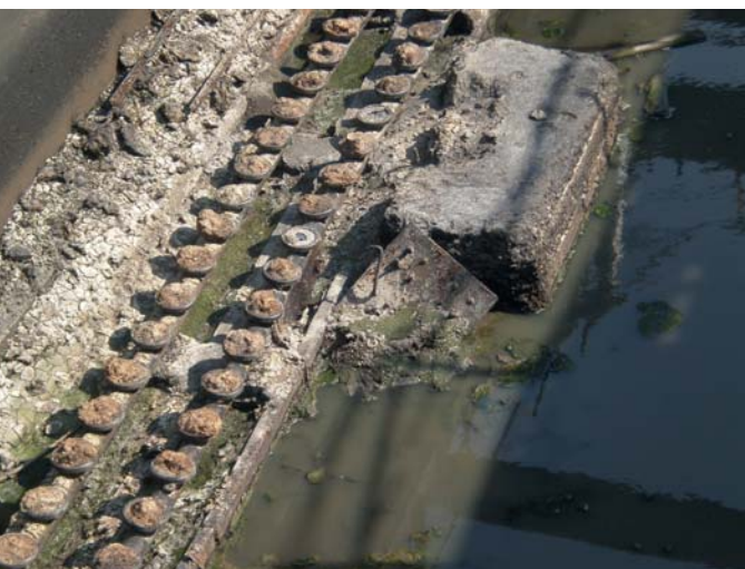
Рис. 3. Результат отсутствия решеток в технологической схеме: проблемы при эксплуатации азротенков
