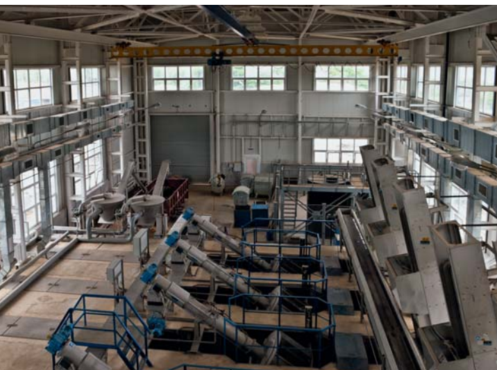
Рис. 5. Цех механической очистки с решетками грубой (на заднем плане) и тонкой очистки (на переднем плане)
